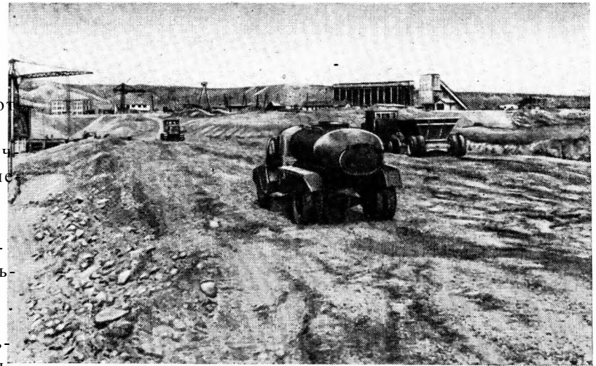
Уплотнение и увлажнение грунта.
