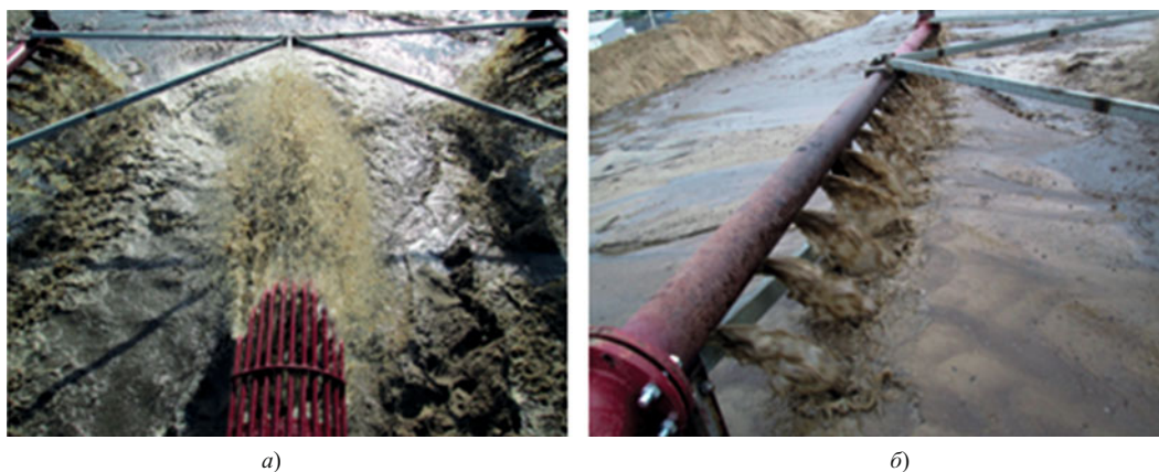
Рис. 6. Намыв дамбы с использованием сортировочно-распределительного устройства: а — намыв центральной части из мелких фракций и отсева; б — фрагмент намыва левой боковой призмы дамбы из отсортированных фракций
