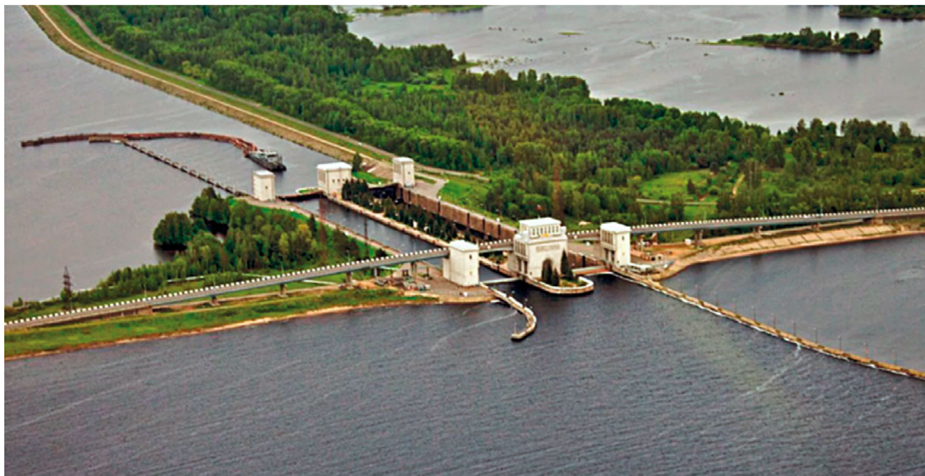
Рис. 1. Шлюзы Нижегородской ГЭС в Городце
