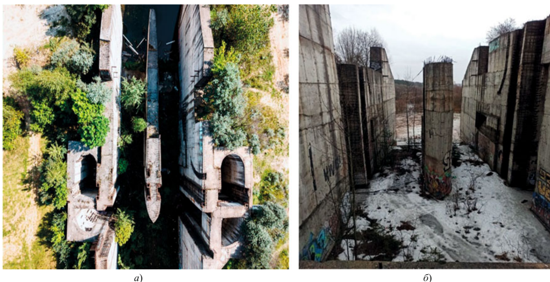
Рис. 3. Вид сверху (а) и поперечного сечения (б) возведённой части водосброса, фото авторов 2022 г. и 2023 г.
