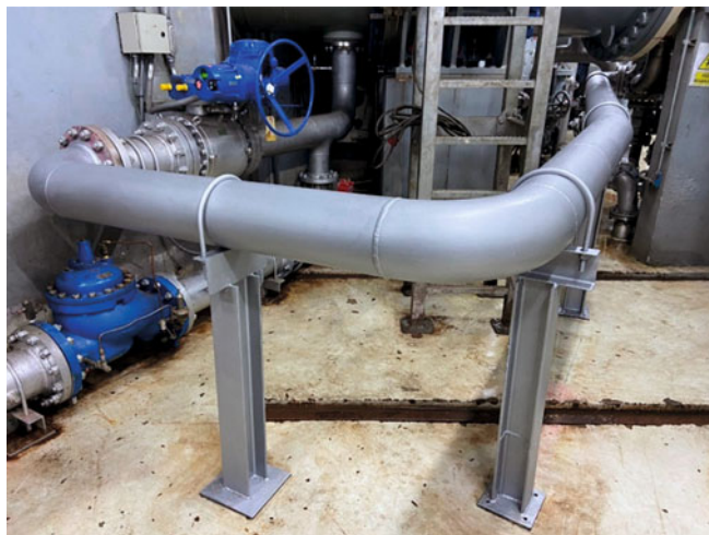
Рис. 13. Временный байпас, соединяющий осушение напорного водовода с осушением спиральной камеры гидротурбины.
