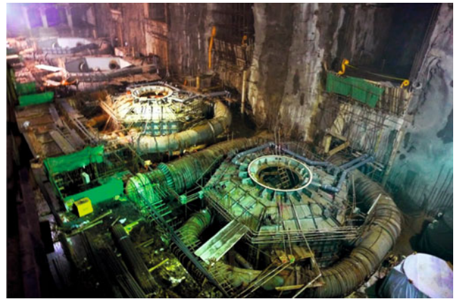
Рис.10. Распределители гидротурбин ковшового типа до бетонирования
