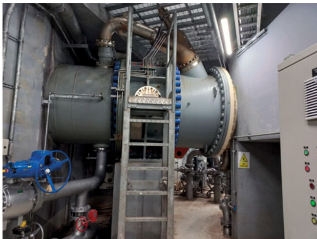
Рис. 11. Дисковый затвор с байпасом
