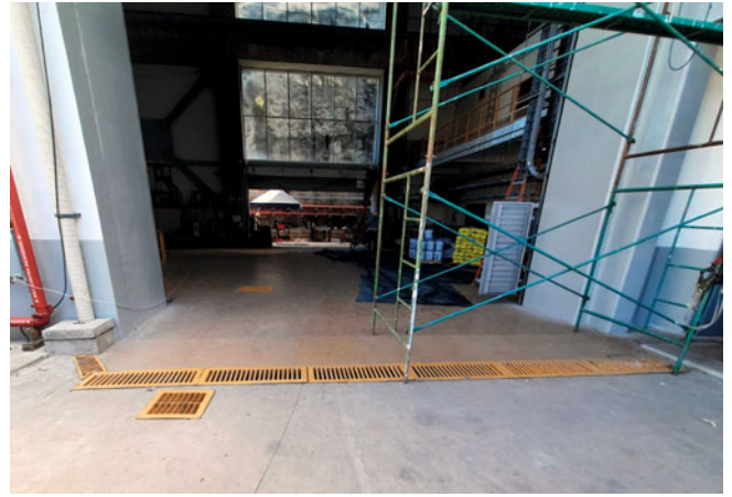
Рис. 8. Сквозной проезд здания ГЭС с дренажным каналом перед воротами
